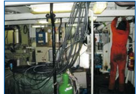
Werk in uitvoering: bekabeling.
