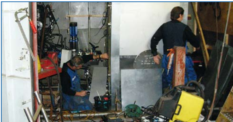
Isolatiewerkzaamheden bezinktank en dagtank.
