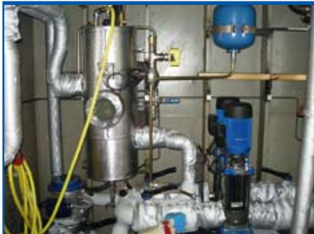
Heetwatersysteem voor tankverwarming.
