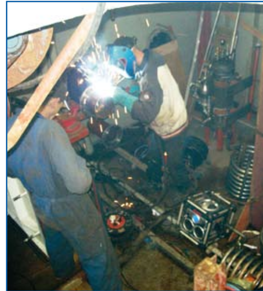
Werkzaamheden aan bezinktank en verwarmingsspiralen.
